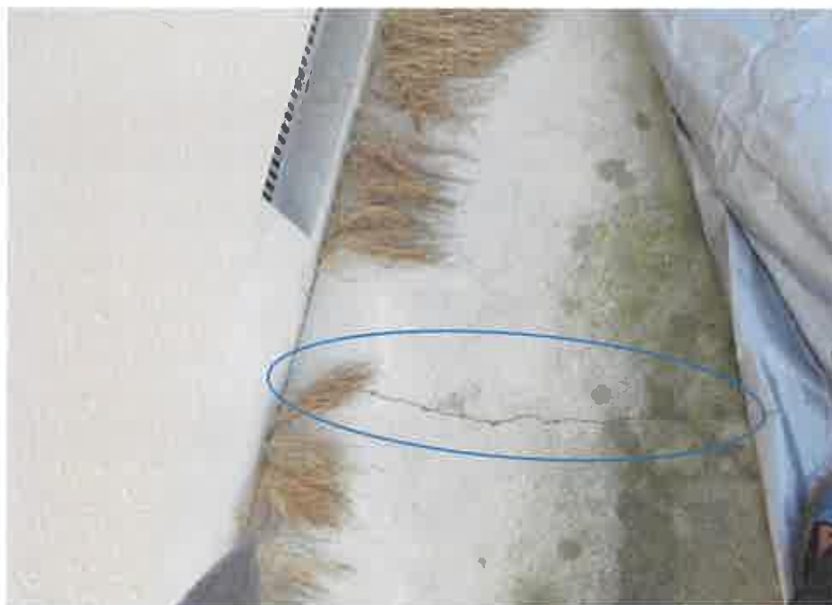
物件1:1階犬走り部分の亀裂
