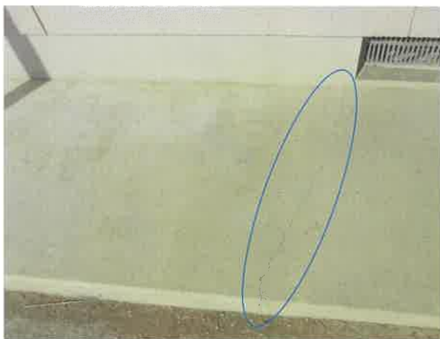
物件1:1階犬走り部分の亀裂
