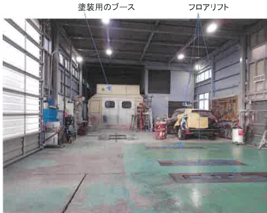
物件1:1階作業室の状況
