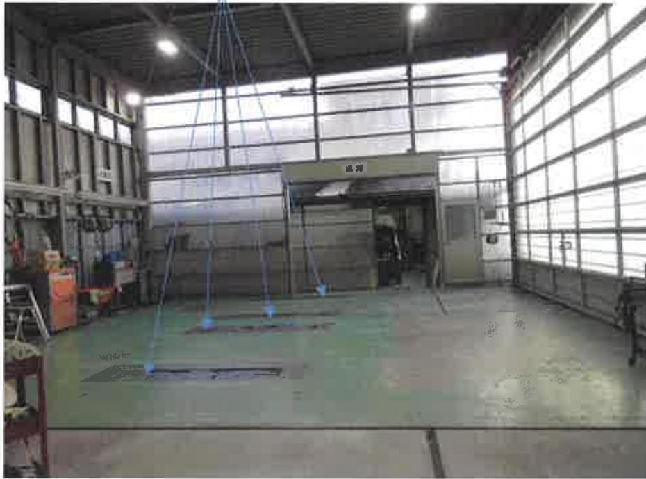
物件1:1階作業室の状況
