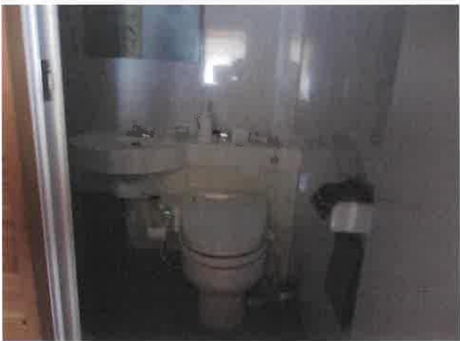
物件1:2階ユニットバス・洗面の状況
