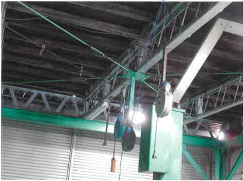
物件2:1階作業室の状況
