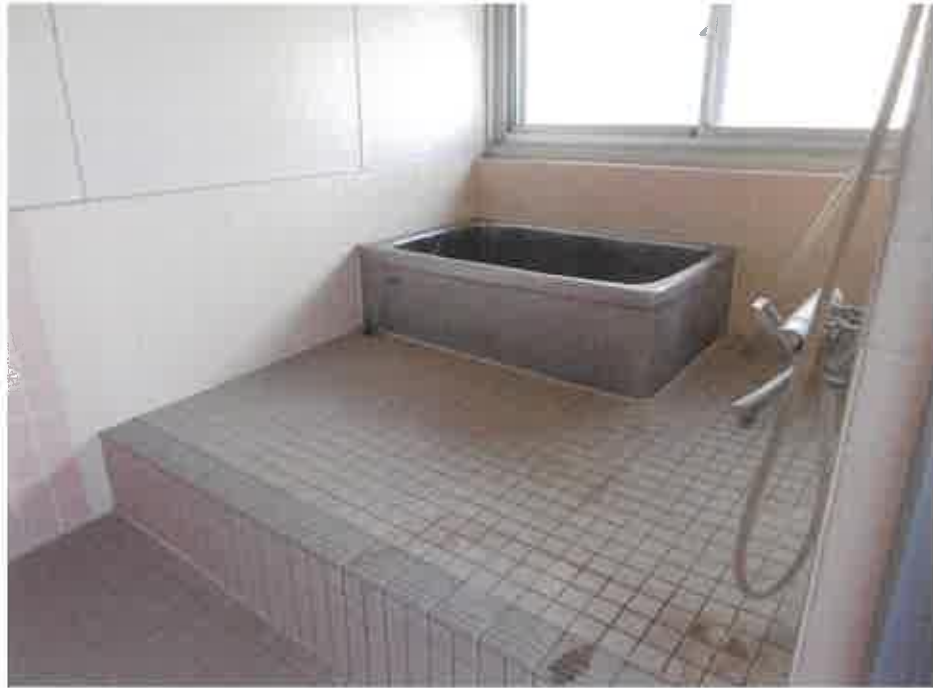
物件2:2階浴室の状況
