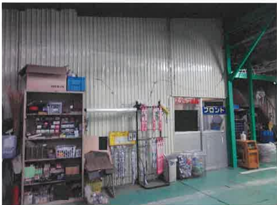
物件2:1階作業室の状況
