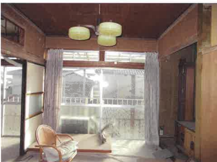
物件2:2階床の間のある和室の状況
