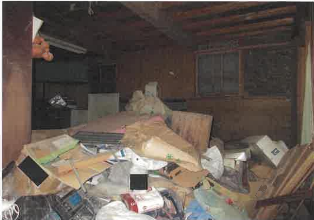
物件2未登記附属建物1の1階物置の状況
