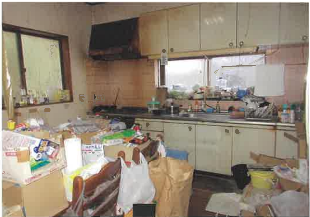
物件2主である建物の台所の状況
