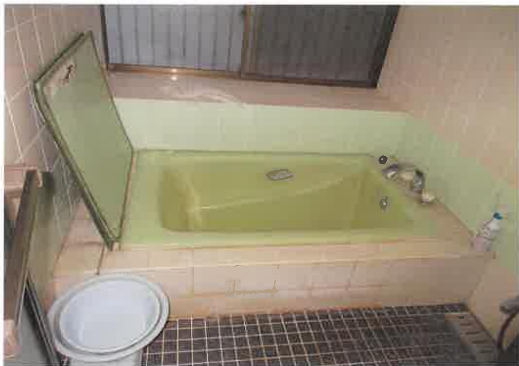
物件2主である建物の浴室の状況
