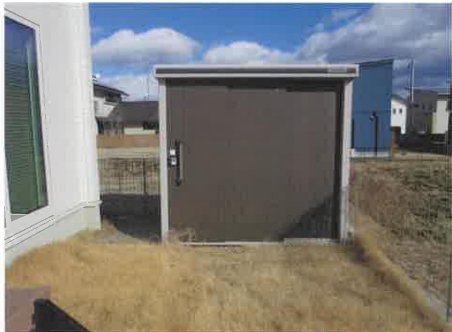
物件1の南東端にある簡易物置(動産)
