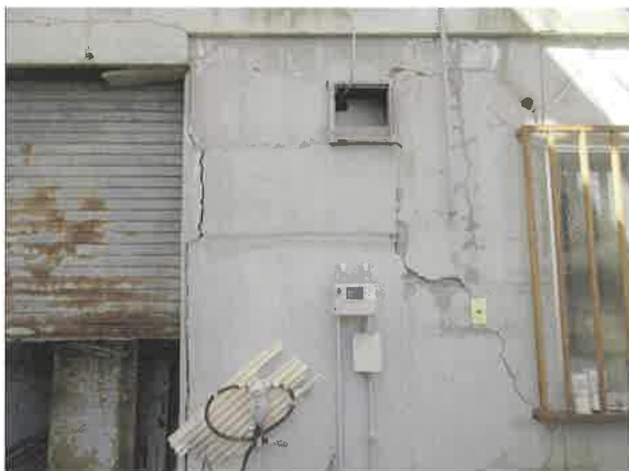
物件2:東側外壁の亀裂
