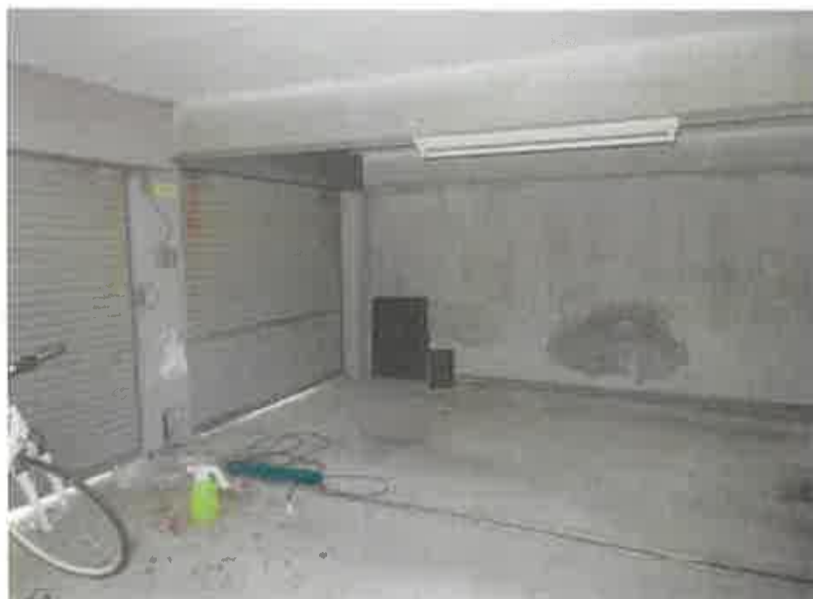
物件3:附属建物符号1の状況 No. 22
