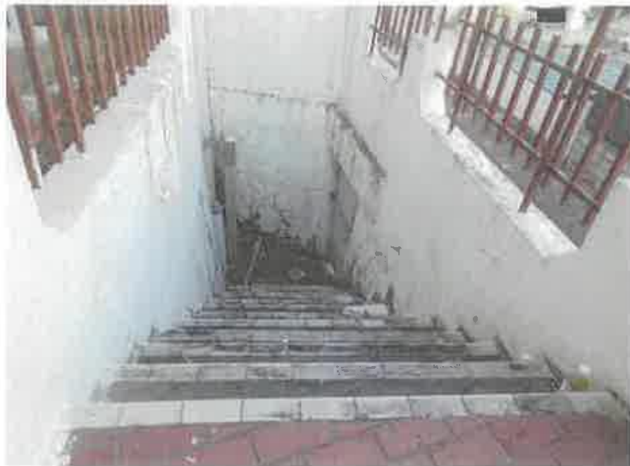
物件1北東側階段の状況
