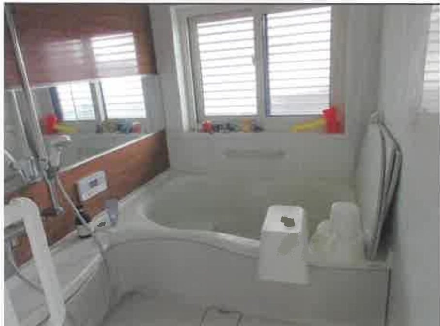
物件2:1階浴室の状況
