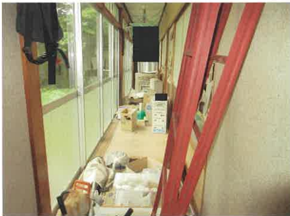
物件1:主である建物1階の広縁の状況
