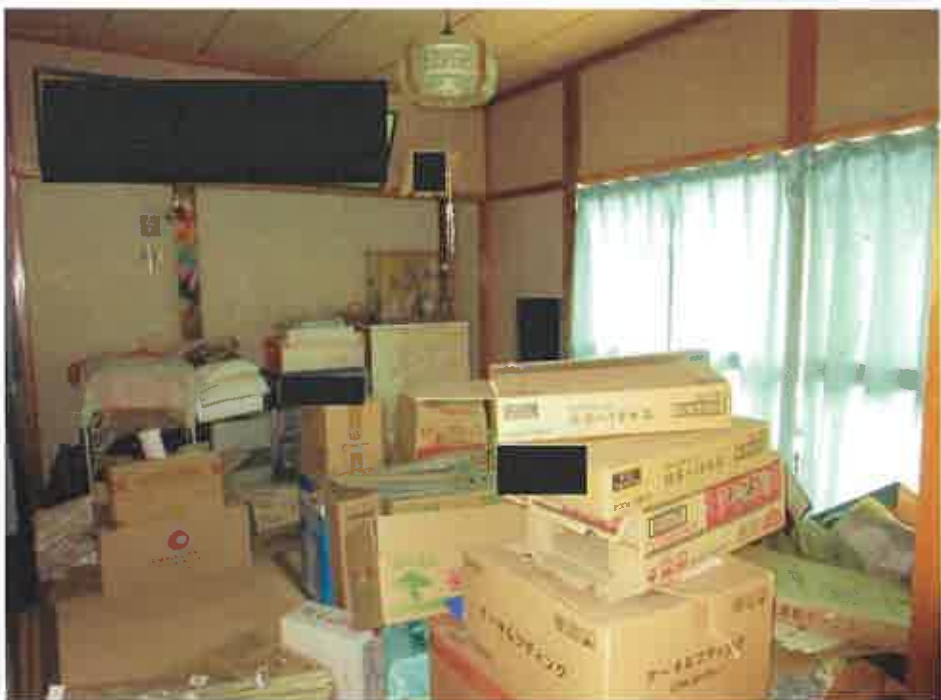
物件1:主である建物1階の東側和室の状況 No. 6
