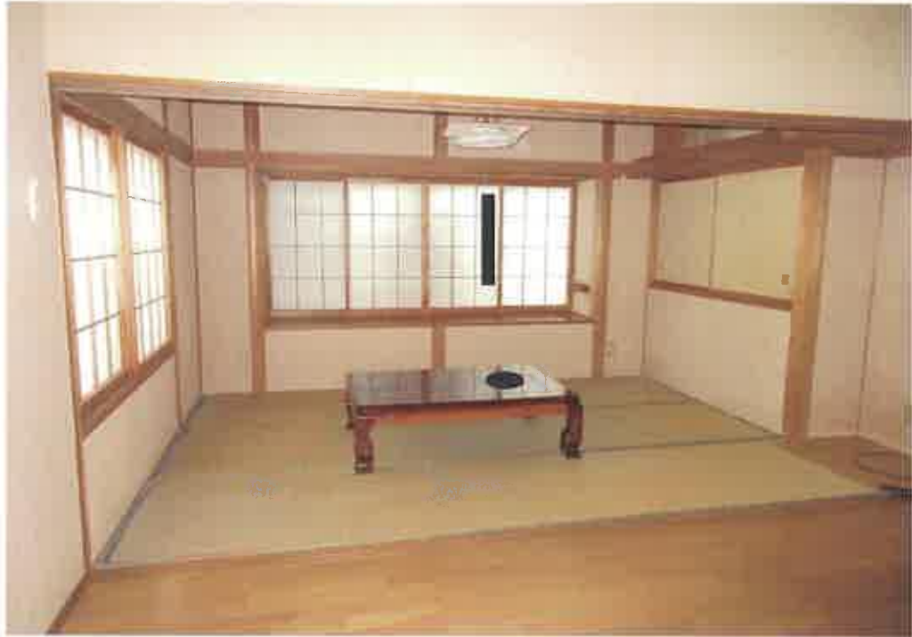
物件2: 1階東側和室の状況
