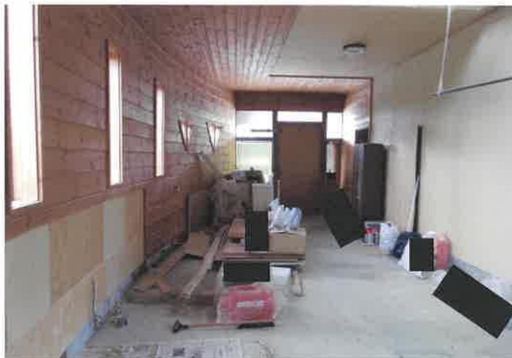
物件2: 1階店舗部分の状況
