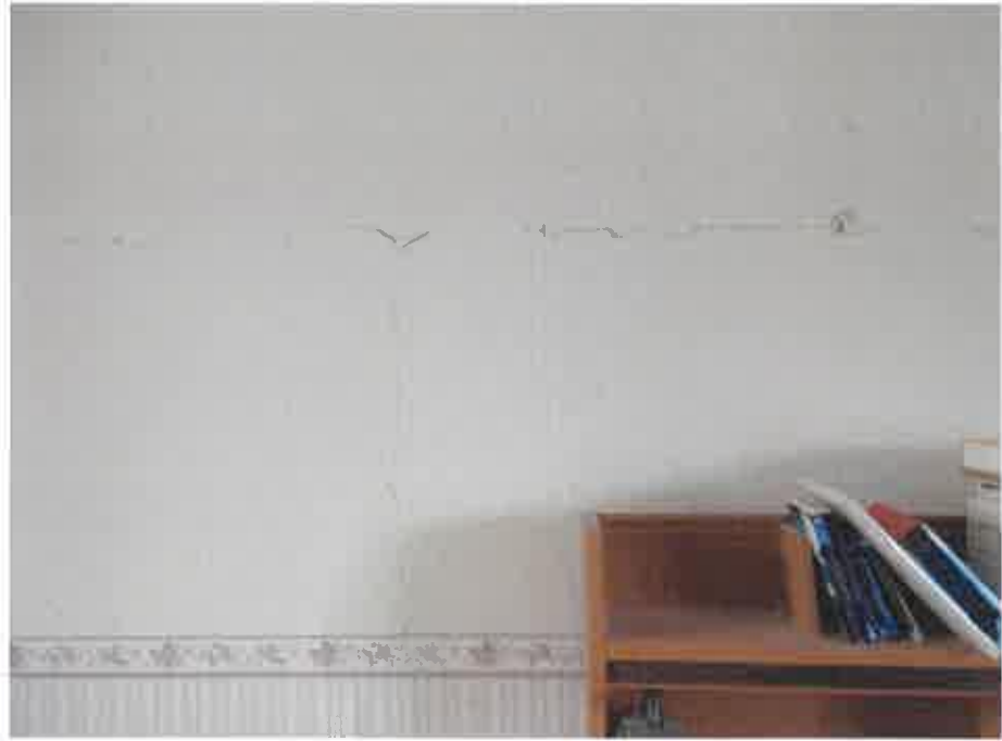
物件2主である建物:2階東側洋室の壁の亀裂
