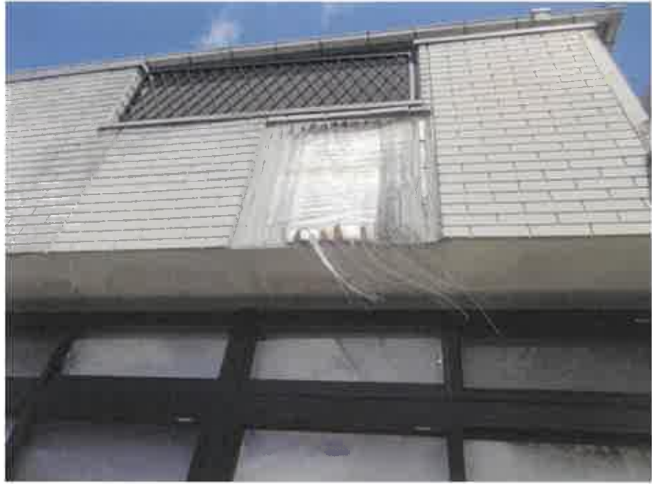
物件2: 外壁タイルの剥離部分
