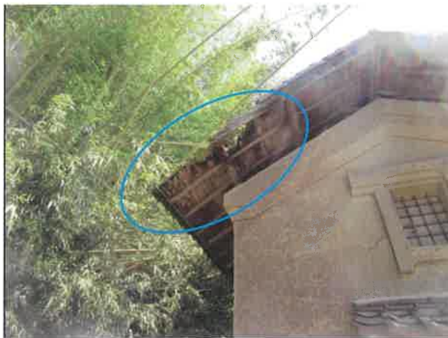
物件3の屋根の破損状況
