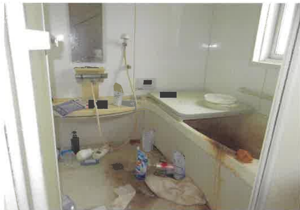
物件3:1階浴室の状況
