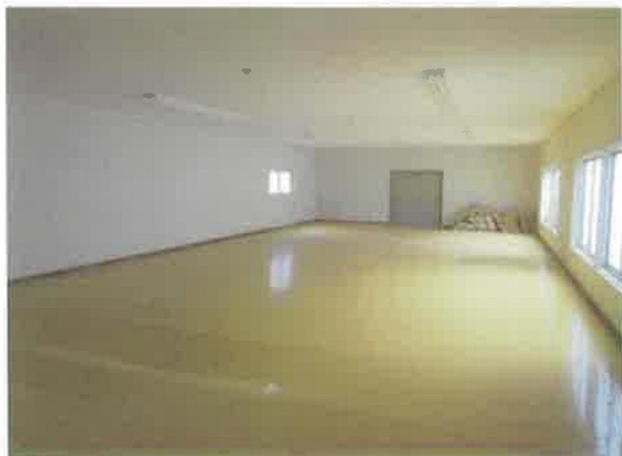
物件4:附属建物符号2西側倉庫の状況
