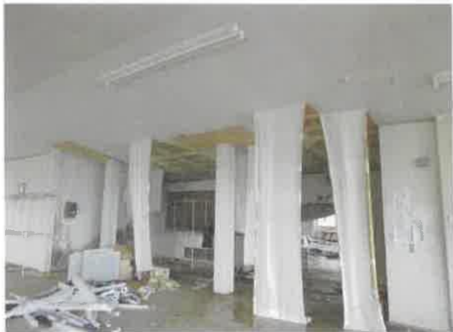
物件4:主である建物1階東側工場の状況 (雨漏りで垂れ下がった天井クロス)
