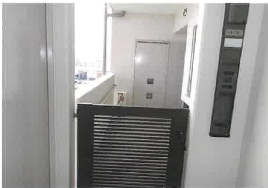
専有部分:専用ポーチ付近の状況
