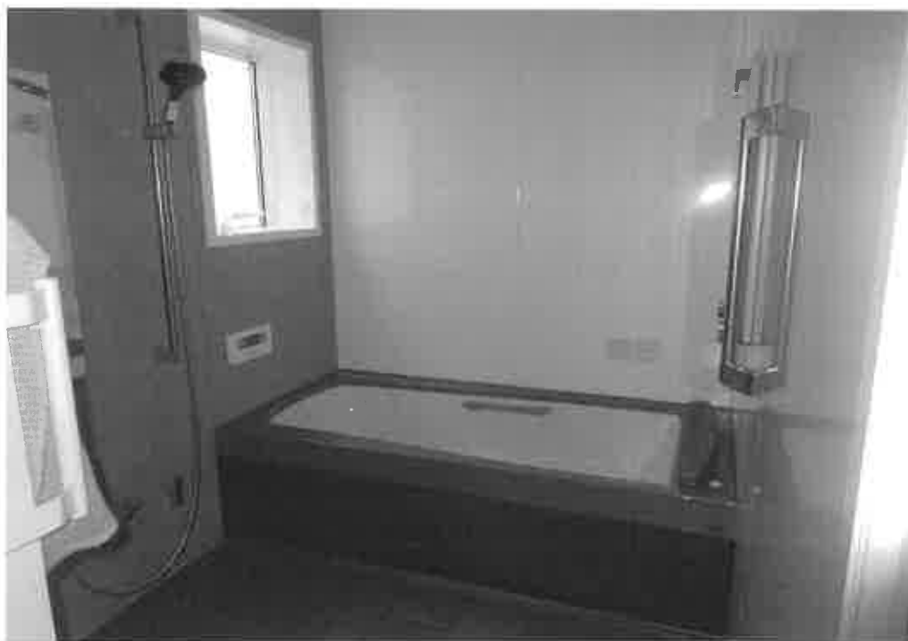
物件2:1階浴室の状況
