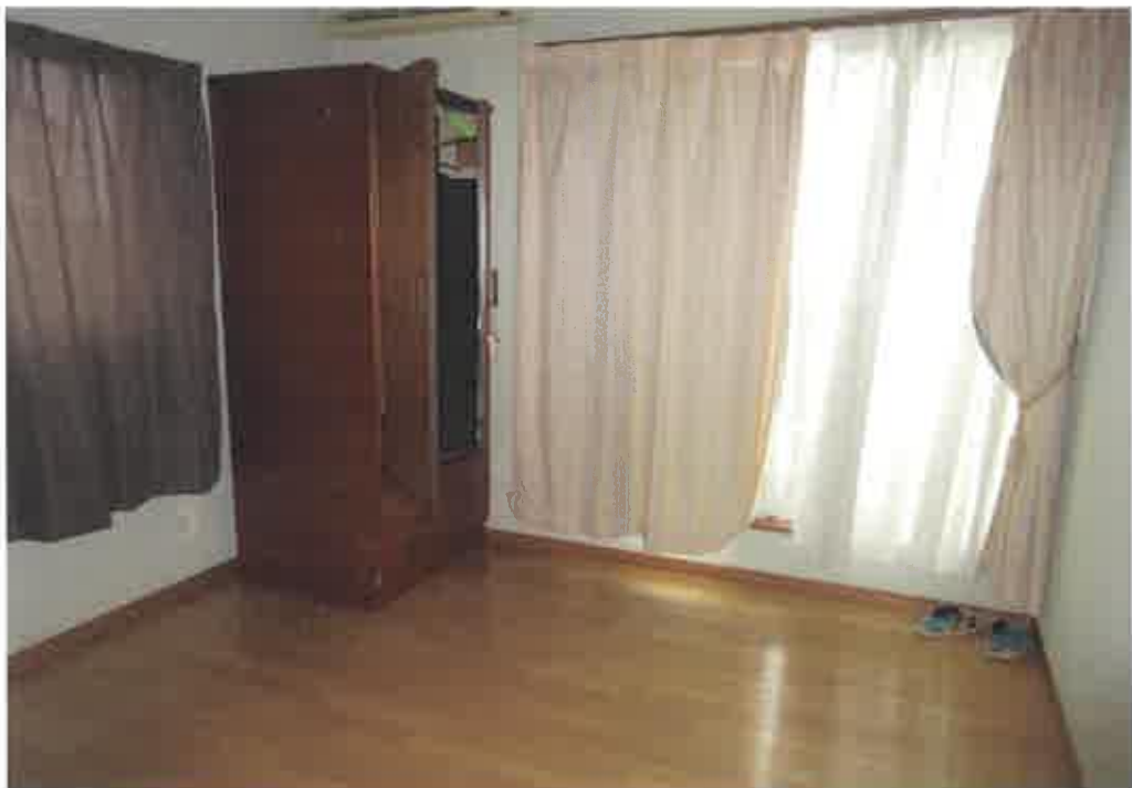
物件2:2階東側洋室の状況
