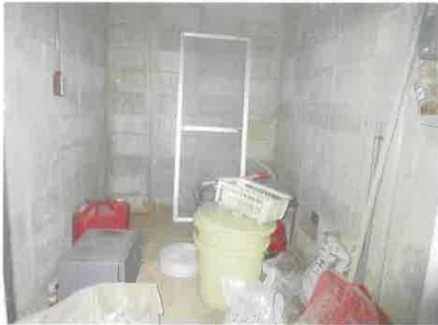
物件3:附属建物符号2の東側倉庫の状況 No. 23
