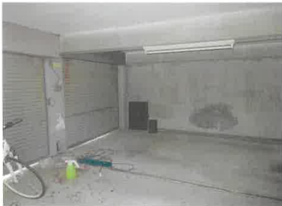
物件3:附属建物符号1の状況 No. 22
