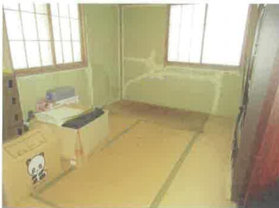
物件3主である建物:1階東側和室の状況
