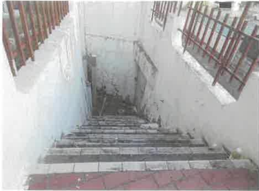
物件1北東側階段の状況
