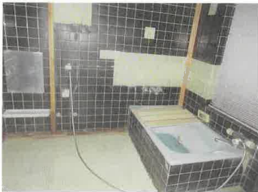
物件3主である建物:1階浴室の状況
