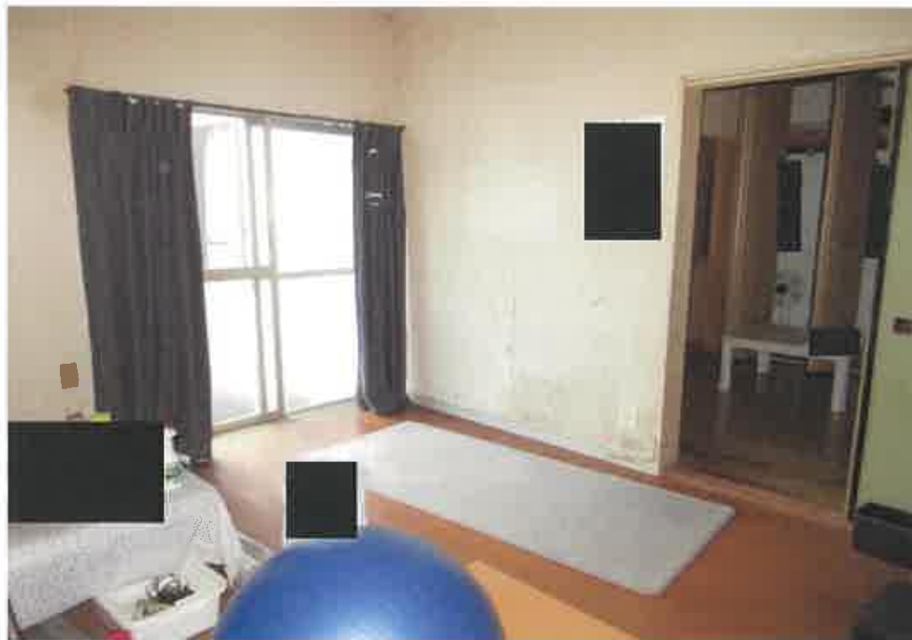
物件2:台所に接する洋室の状況
