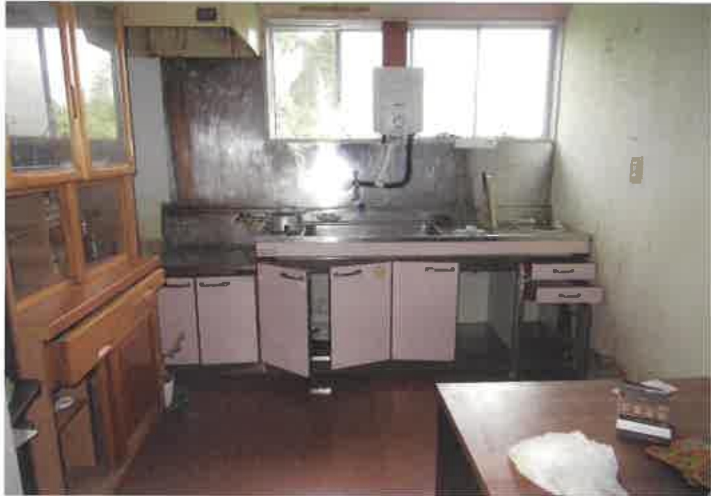
物件2:台所の状況
