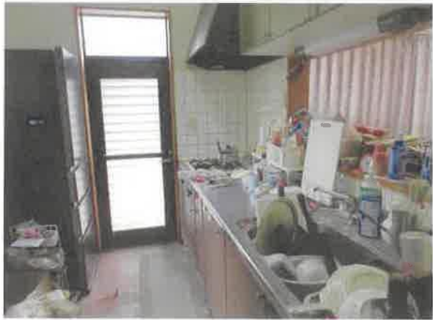
物件3:1階台所の状況
