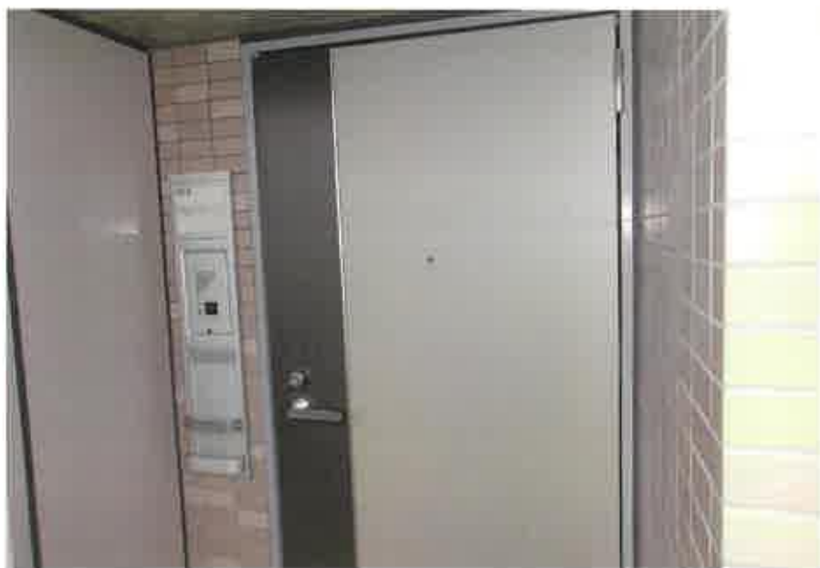
専有部分:玄関付近の状況
