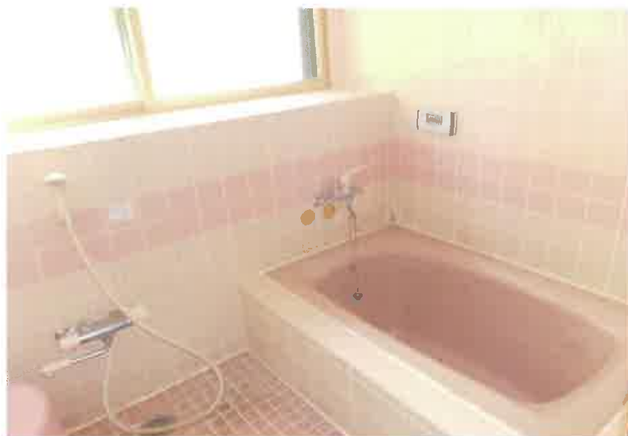
物件7:1階浴室の状況
