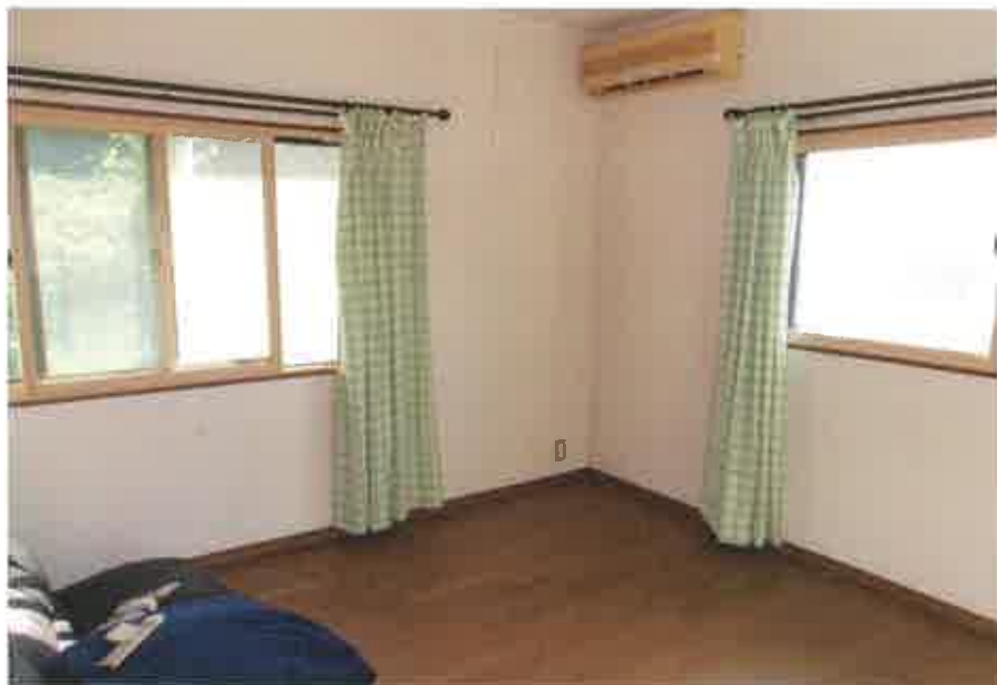
物件7:2階南西側洋室の状況
