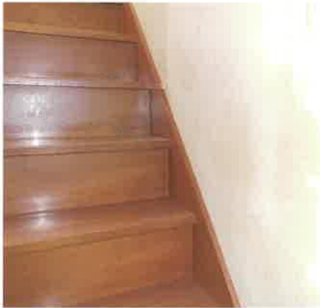
物件7:1階階段脇壁面の状況
