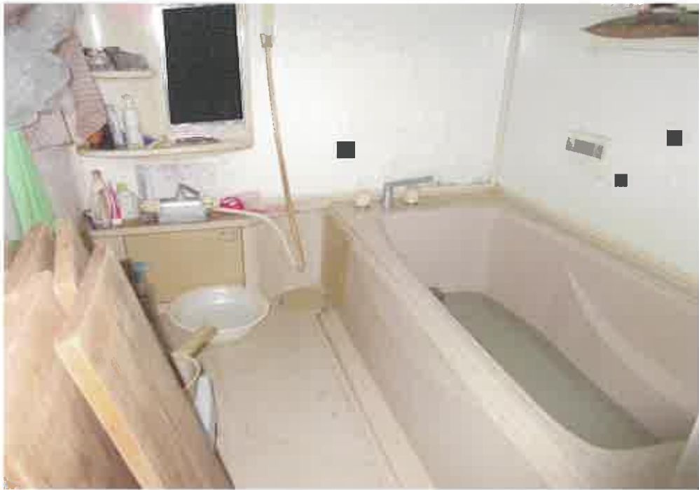
物件2主である建物:1階浴室の状況
