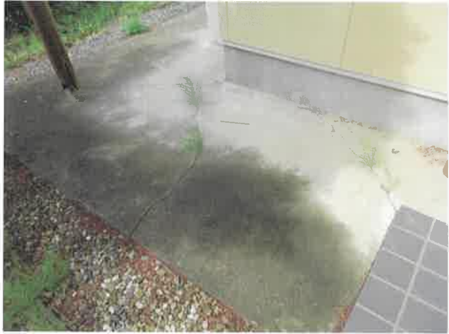
物件3:東側玄関付近叩きの亀裂の状況
