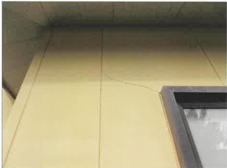
物件3:西側外壁の亀裂の状況
