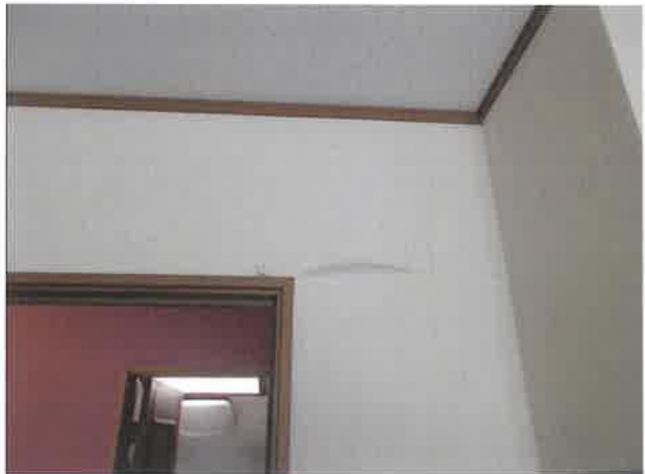
物件3：西側2階廊下の壁クロス剥離の状況
