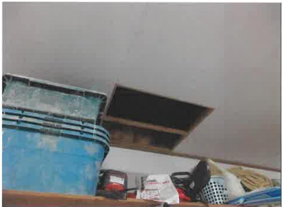
物件4:倉庫の天井板が外れた箇所
