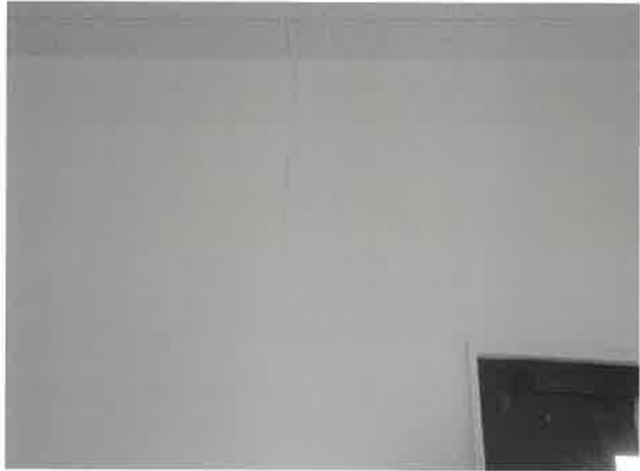
物件4:事務室玄関上部の壁の亀裂
