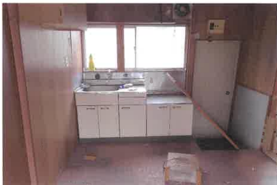
物件17:台所の状況
