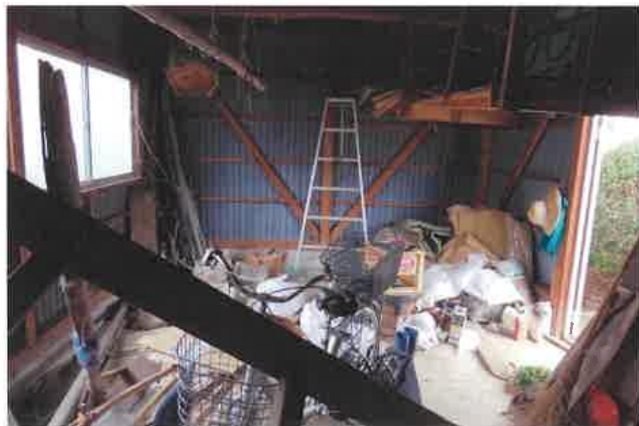
物件13附属建物符号1:内部の状況
