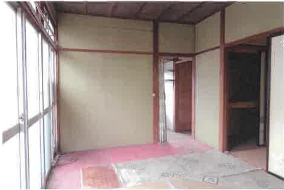
物件14:南側和室6帖の状況
