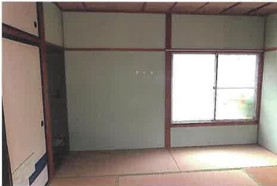
物件15:北側和室6帖の状況
