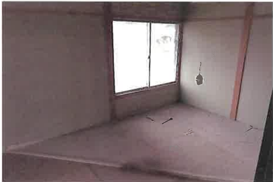
物件14:北側和室6帖の状況
