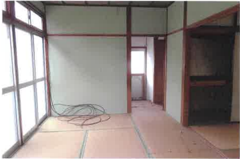
物件15:南側和室6帖の状況
