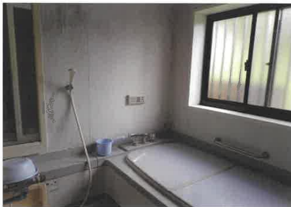
物件2:浴室の状況
