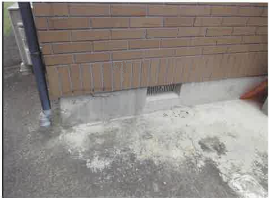
物件3:主である建物の外壁基礎部分の亀裂
