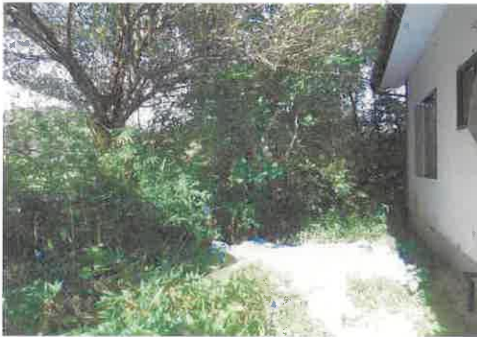
傾斜している部分
