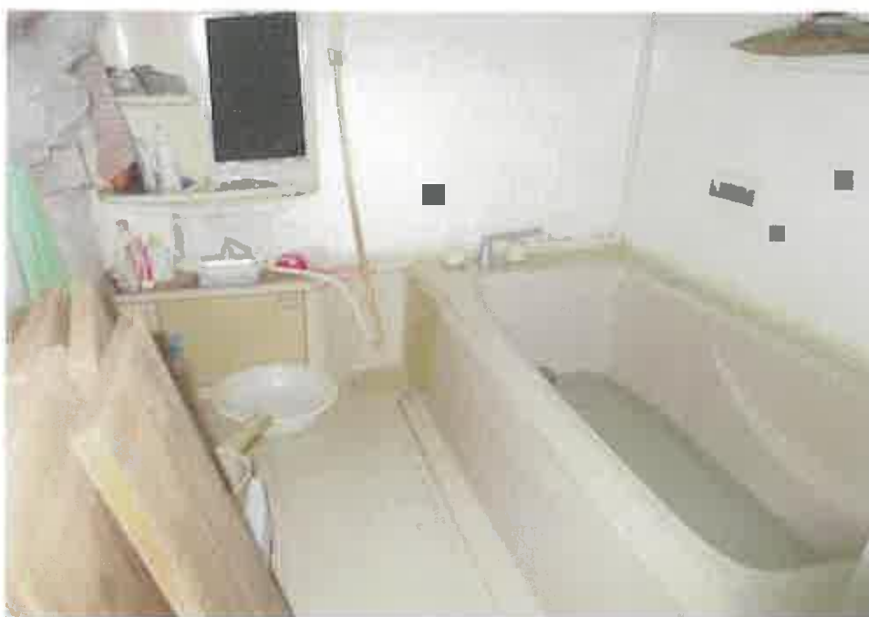
物件2主である建物:1階浴室の状況
