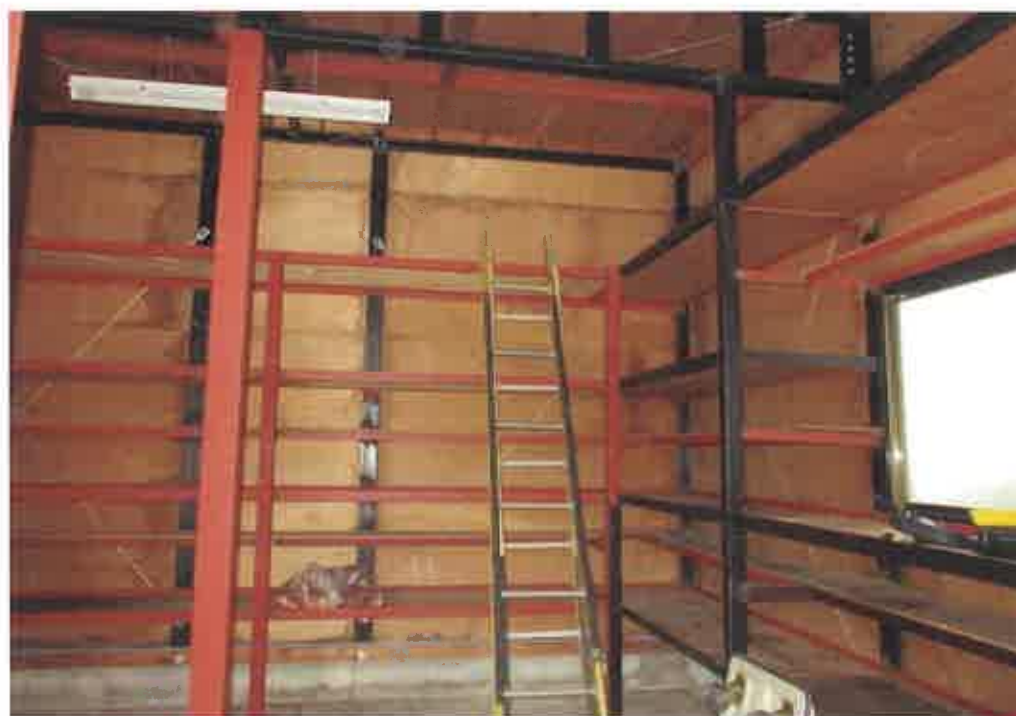
物件3附属建物:1階内部の状況
