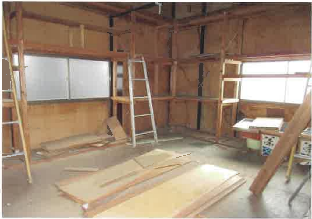
物件3附属建物:2階内部の状況
