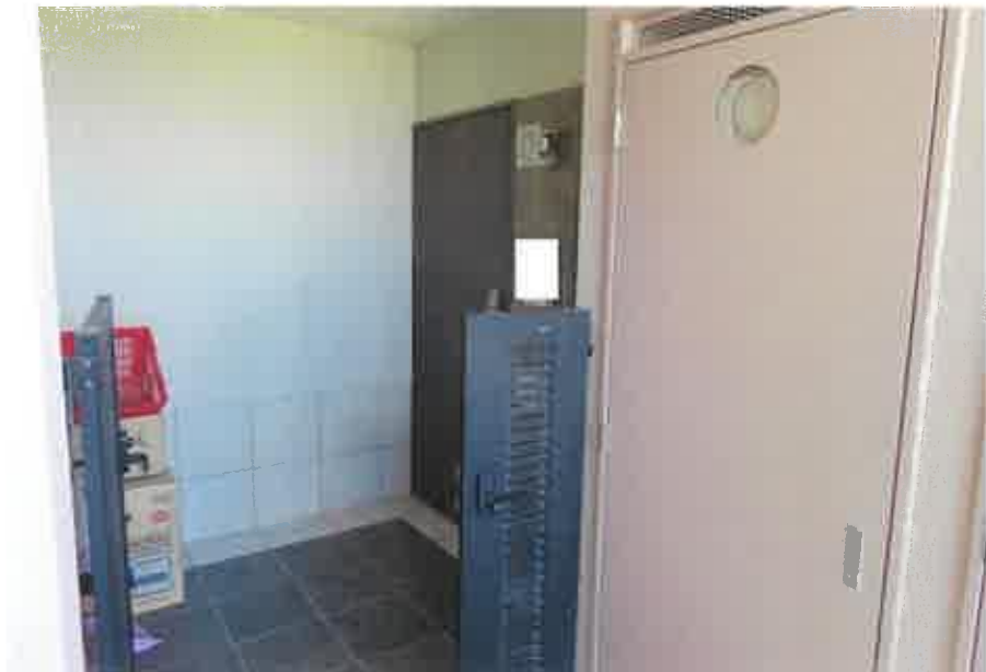
物件1:玄関外(オーナーズコート)の状況
