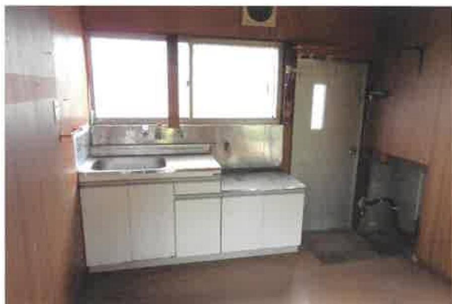
物件22:台所の状況
