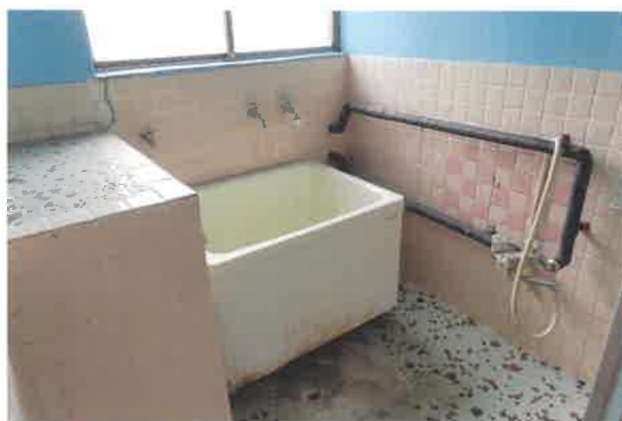
物件21:浴室の状況
