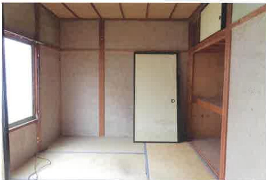
物件21：北西側和室4.5帖の状況
