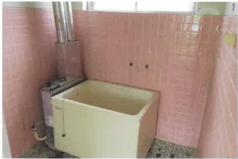
物件23:浴室の状況
