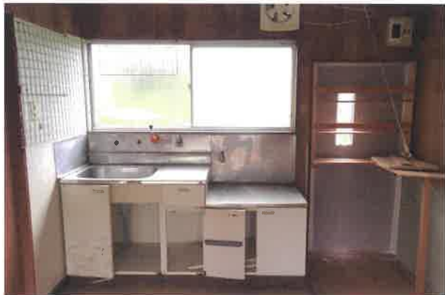
物件23:台所の状況
