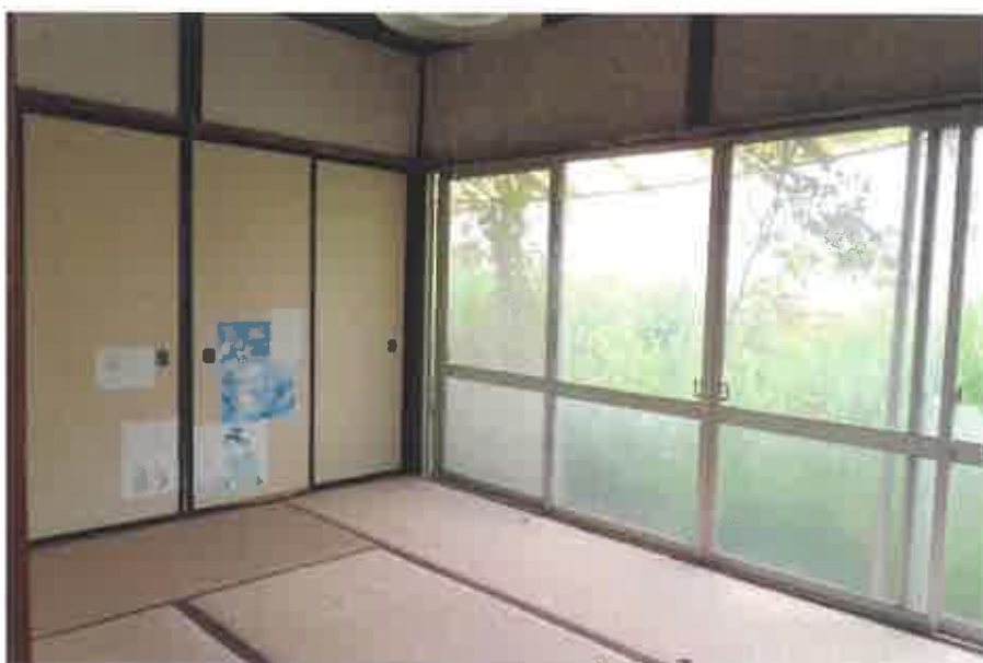
物件24:西側和室6帖の状況
