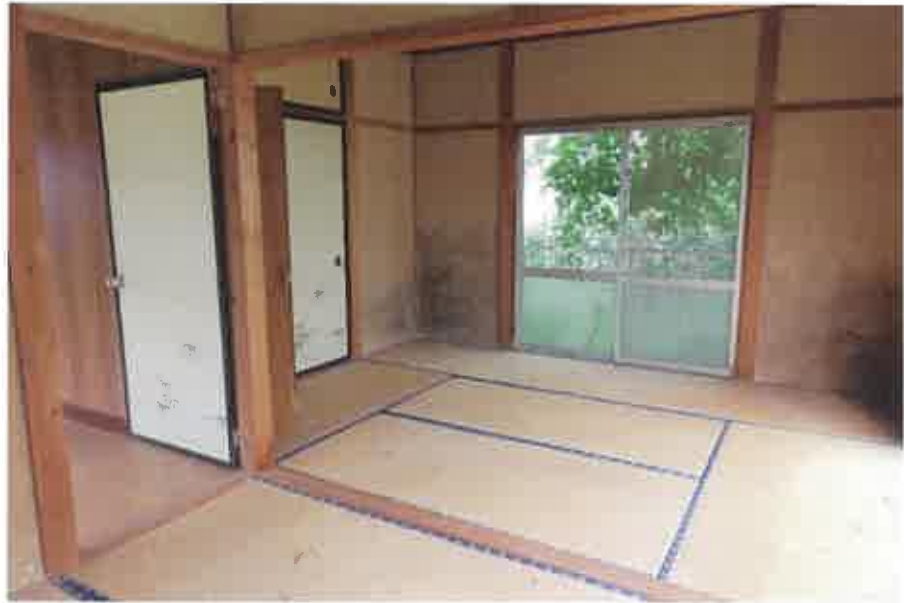
物件19:西側和室4.5帖、南側和室6帖の状況
