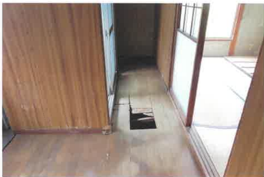
物件21：浴室前の廊下の状況
