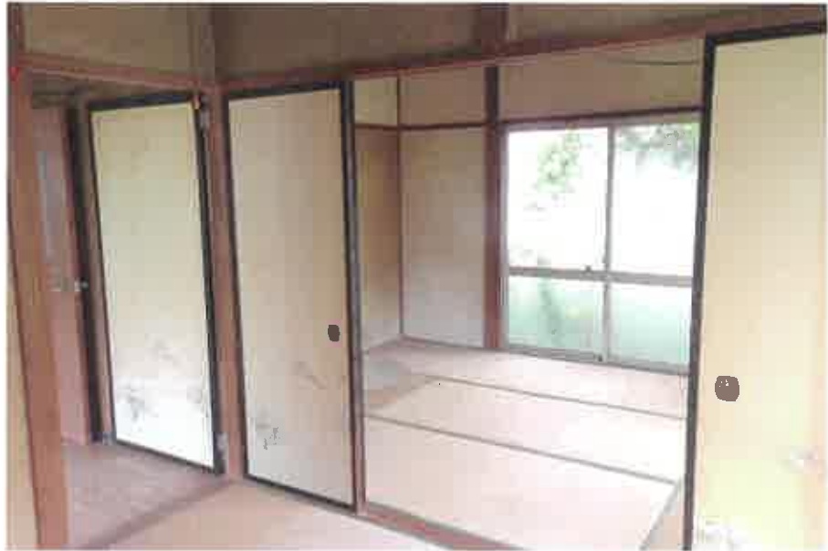
物件20:西側和室4. 5帖、南側和室6帖の状況
