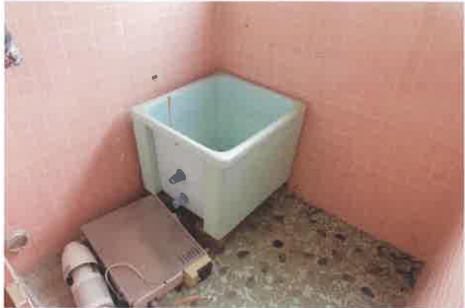
物件19:浴室の状況
