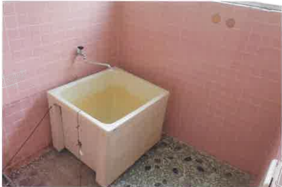
物件20:浴室の状況
