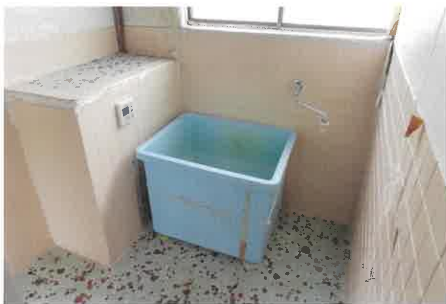
物件22:浴室の状況
