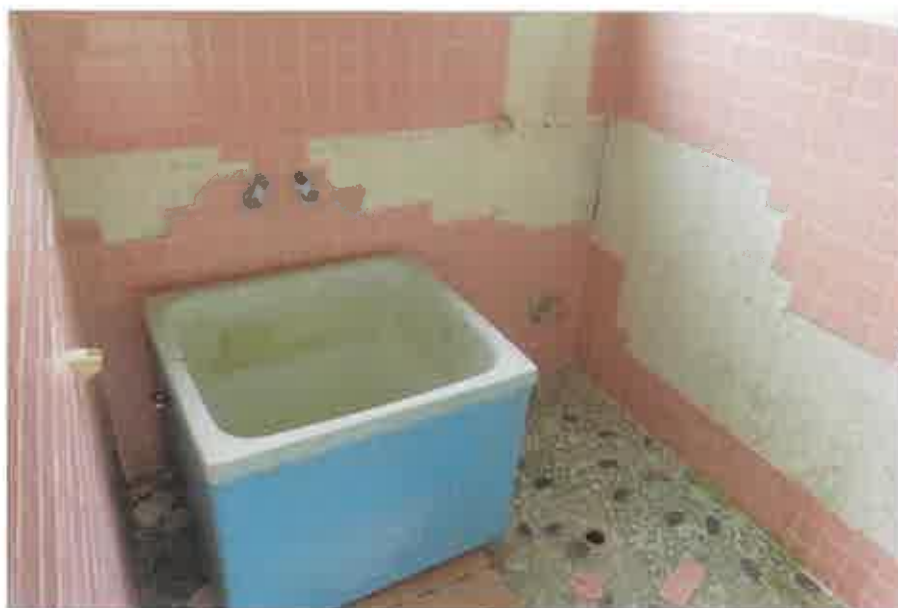
物件24:浴室の状況
