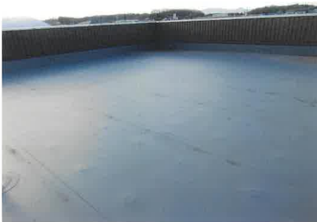
物件1附属建物符号2の屋上の状況
