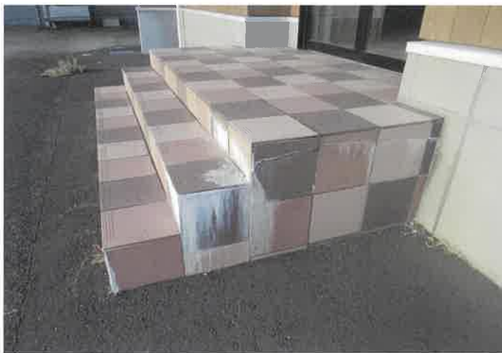
物件1附属建物符号2の玄関ポーチの階段部分側面等のひびの状況
