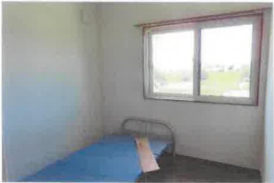
物件2:2階中央洋室の状況
