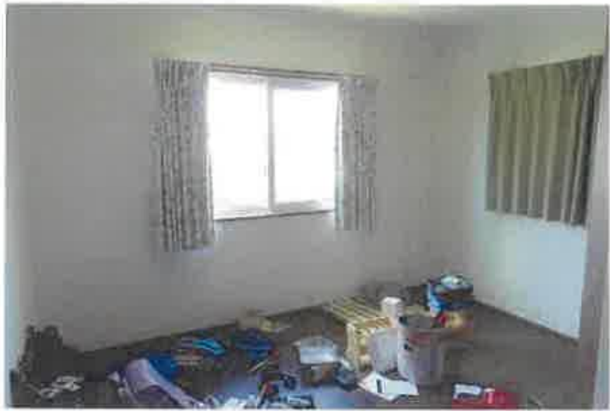
物件2:2階西側洋室の状況
