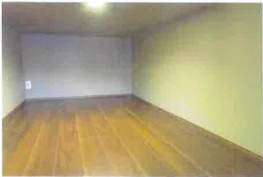
物件2:2階屋根裏の状況
