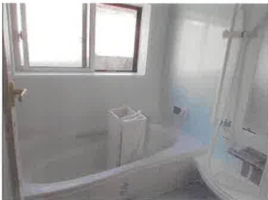
物件7:1階浴室の状況
