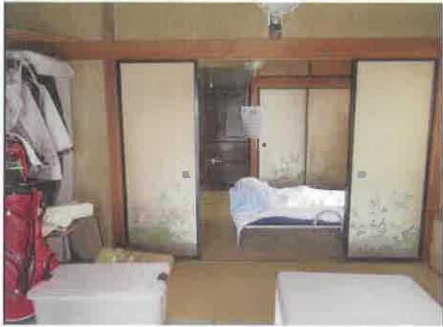
物件7:1階東側和室二間の状況
