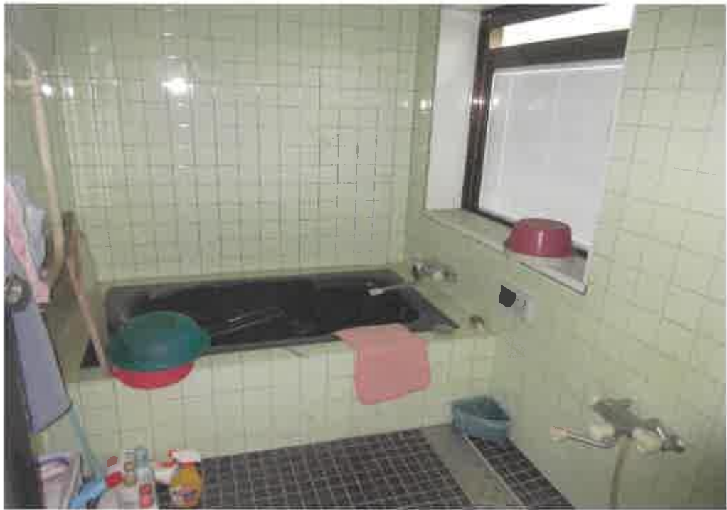
物件2:1階浴室の状況
