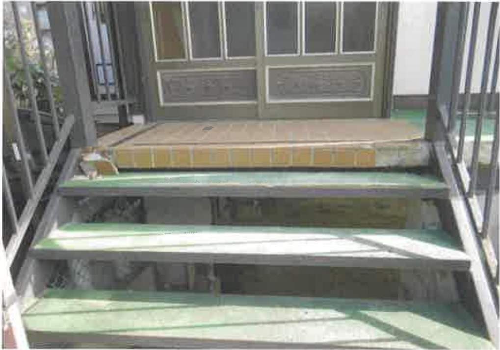
物件2:玄関前の外階段踏込み部分のタイル の剥離等の状況
