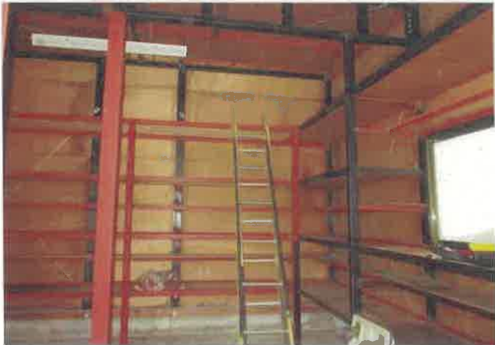
物件3附属建物:1階内部の状況
