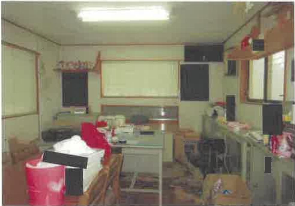
物件2:2階事務所部分の状況
