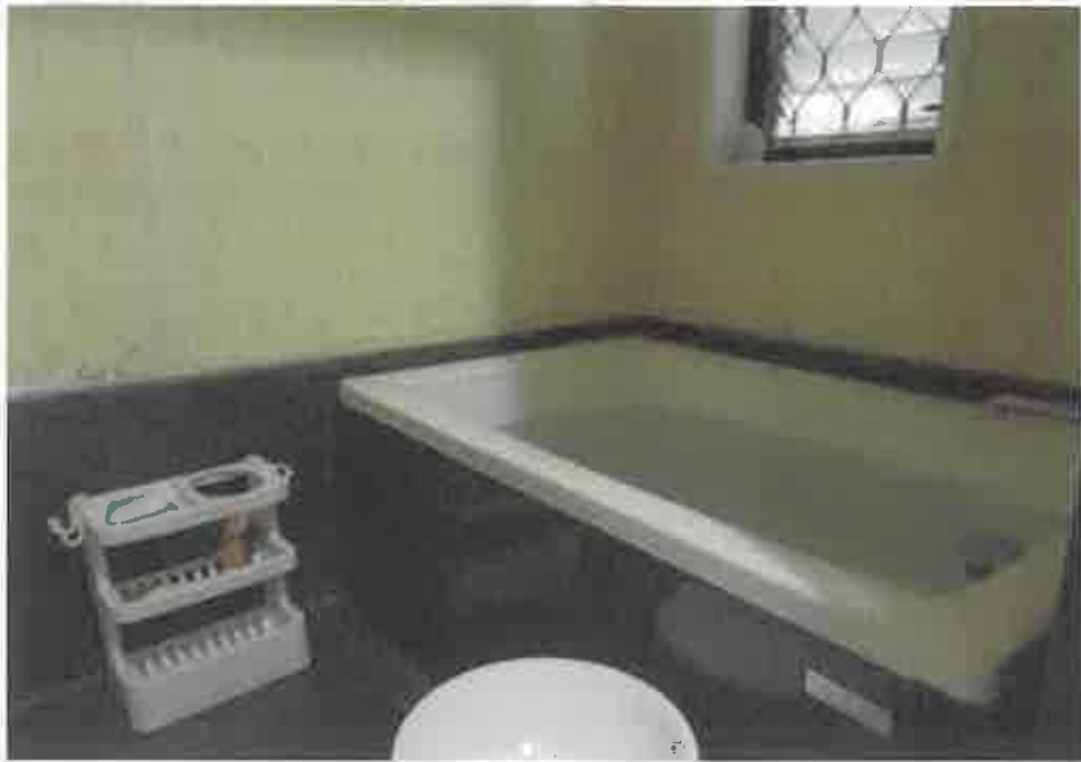
物件3主である建物:1階浴室の状況
