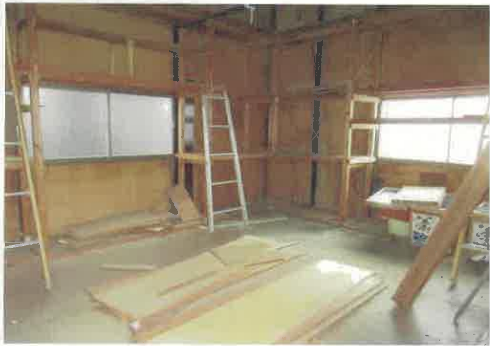
物件3附属建物:2階内部の状況
