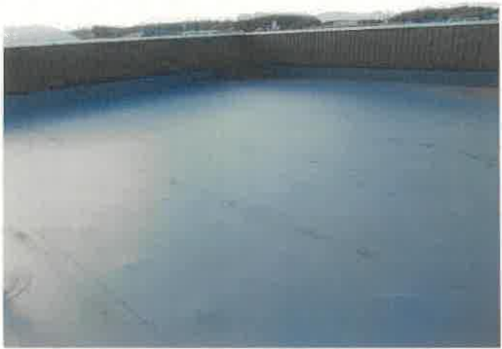
物件1附属建物符号2の屋上の状況
