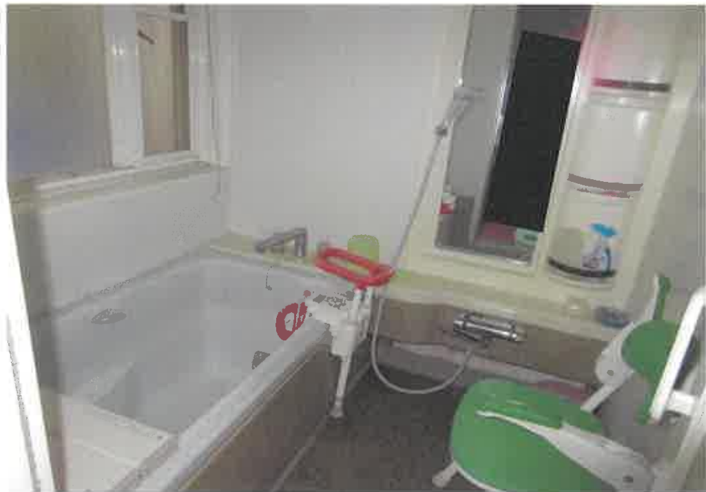
物件1:1階浴室の状況
