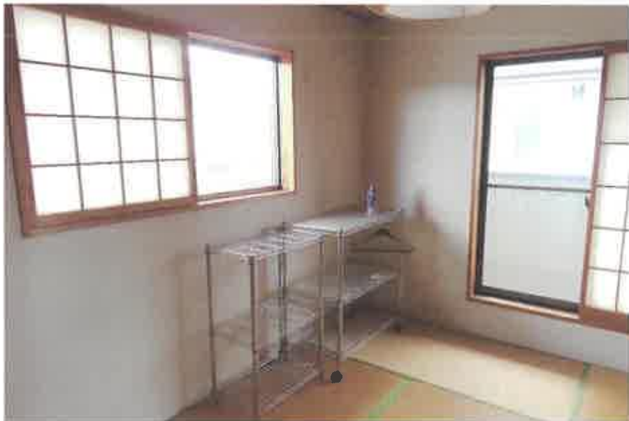
物件2:2階和室の状況
