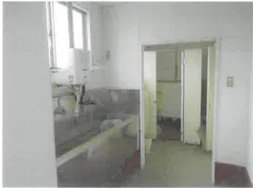
物件5:2階東側洗面所・便所の状況 No. 11
