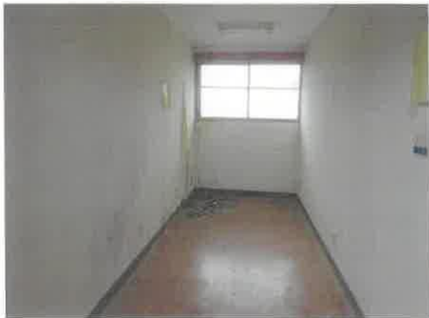
物件5:2階東側事務室の状況 No. 12
