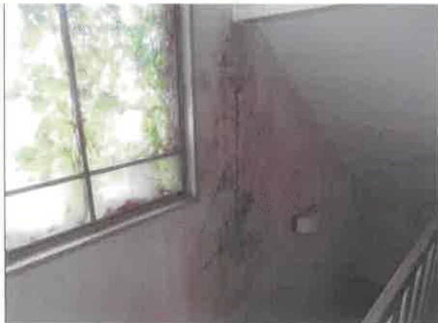
物件8・9:2階 北西側階段の壁の剥離
