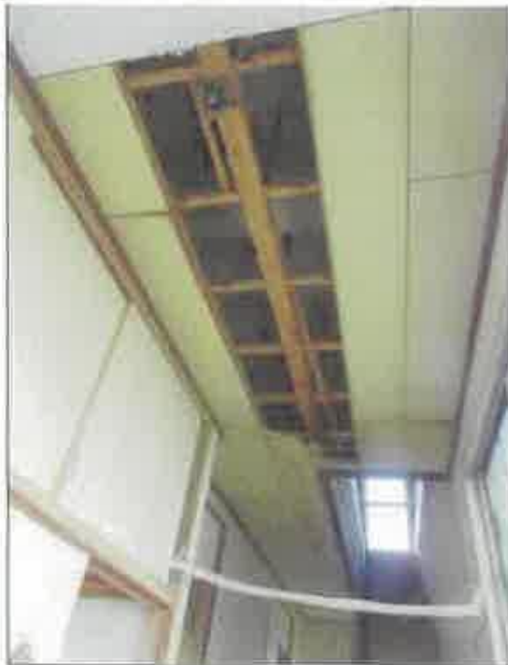
物件8-9:3階 北側廊下の天井の状況
