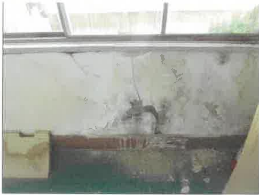
物件8-9:3階 北側廊下の状況
