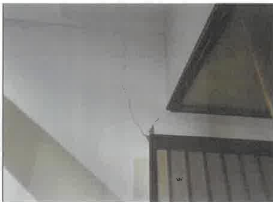
物件8・9:1階 中廊下の壁の亀裂
