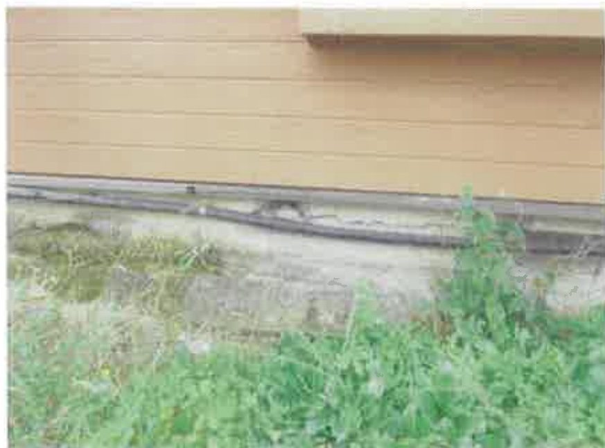
物件8・9:外壁基礎部分の亀裂の状況
