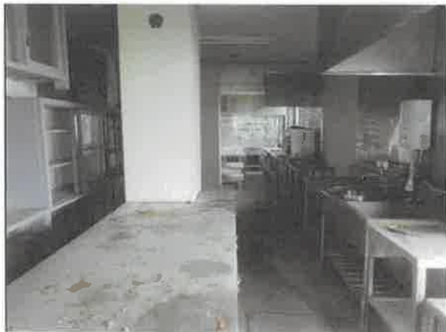
物件8-9:1階 厨房の状況
