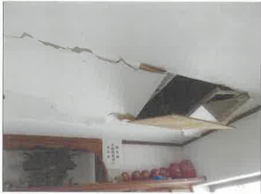
物件8-9:1階 帳場の天井の状況
