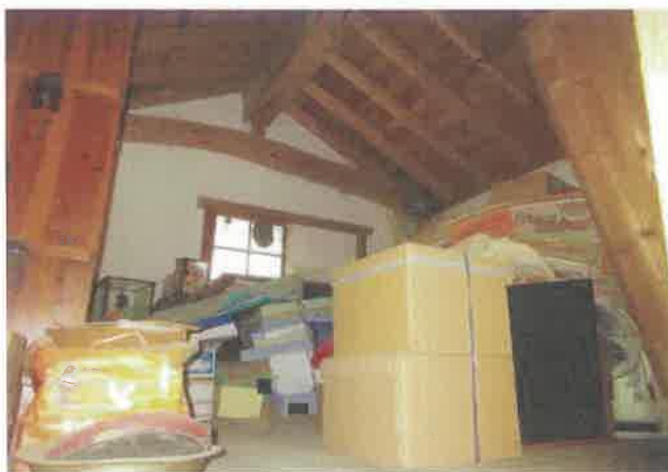
物件5附属建物符号1:2階内部の状況
