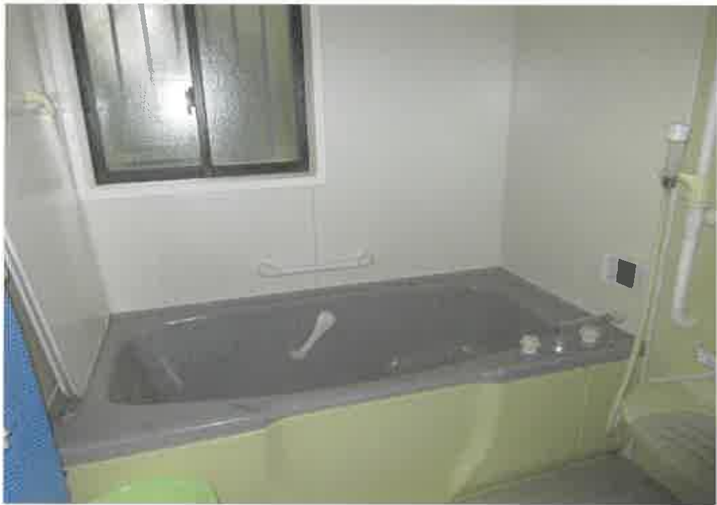
物件2:1階浴室の状況
