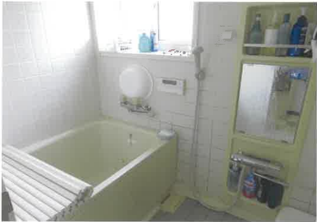
物件2:1階浴室の状況
