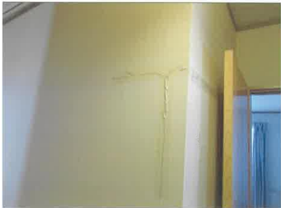
物件1:2階廊下壁面の亀裂
