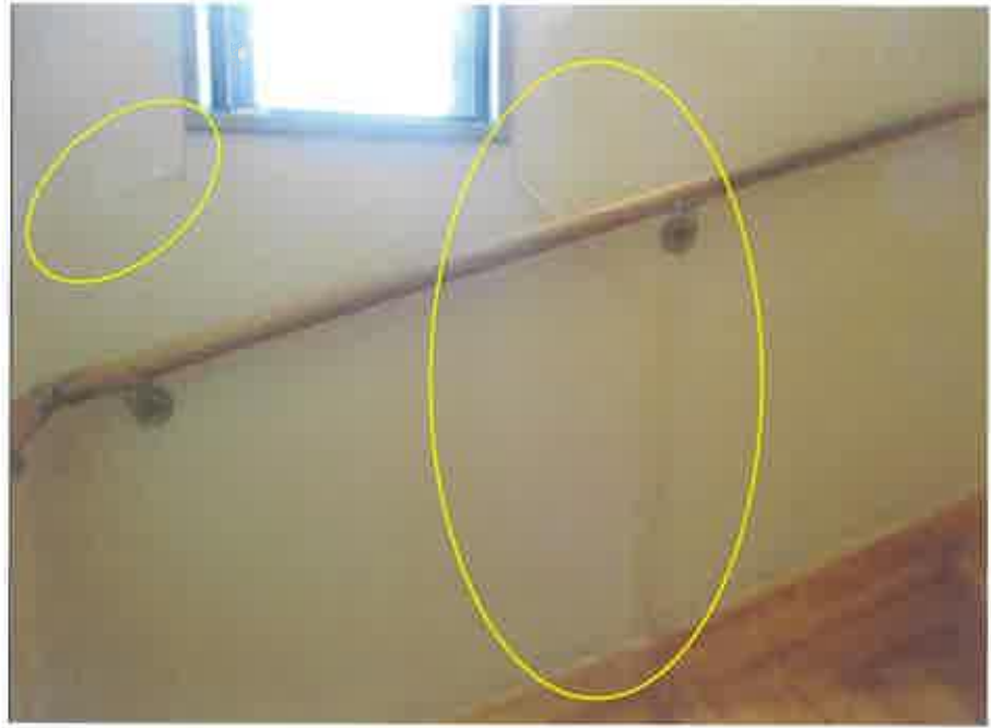
物件1:階段部分壁面の亀裂
