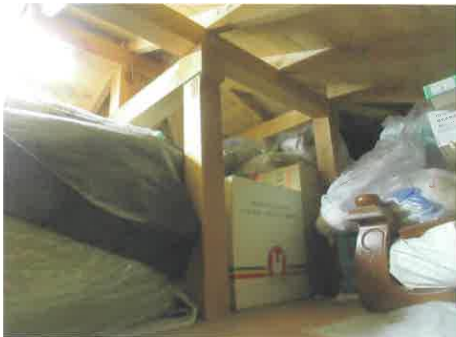
物件1:2階屋根裏部屋の状況
