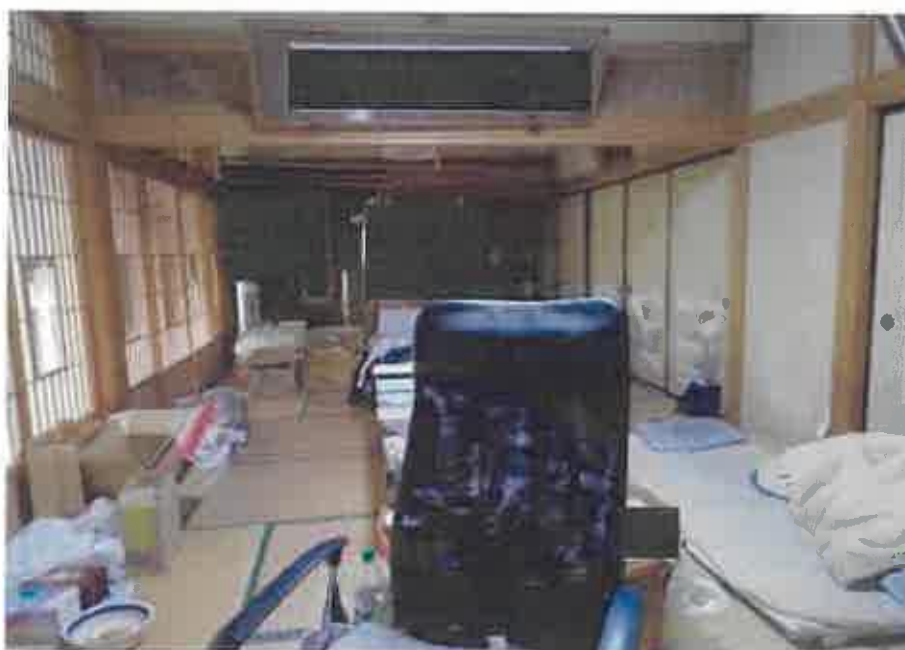
物件2: 広縁に面した和室2室の状況
