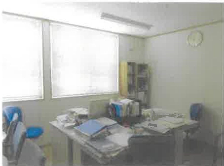
物件1:2階南側事務室の状況
