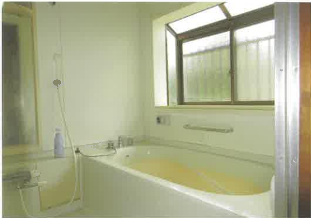
物件2主である建物:1階浴室の状況
