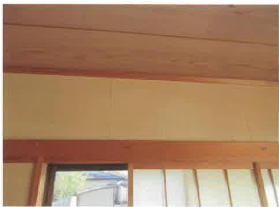
物件5:1階南西側和室の壁の亀裂
